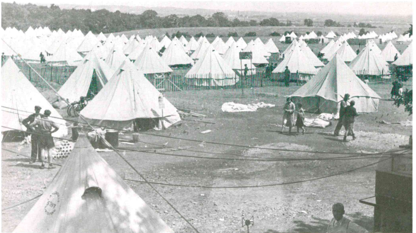
Vista del campamento de Stoneham.
