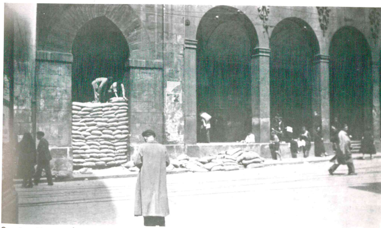
Construcción de un refugio en la Universidad de Deusto.
